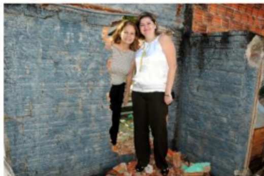
As gestoras Maria Rosival Fernandes e Kelly Sordi visitam o espaço onde será construída a nova sala de espera do ambulatório e o local para a ressonância magnética
